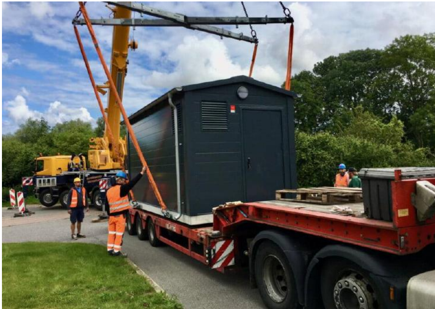
Figur 4. Illustration af bygning til transformer/switchgear og teknikbygning.
